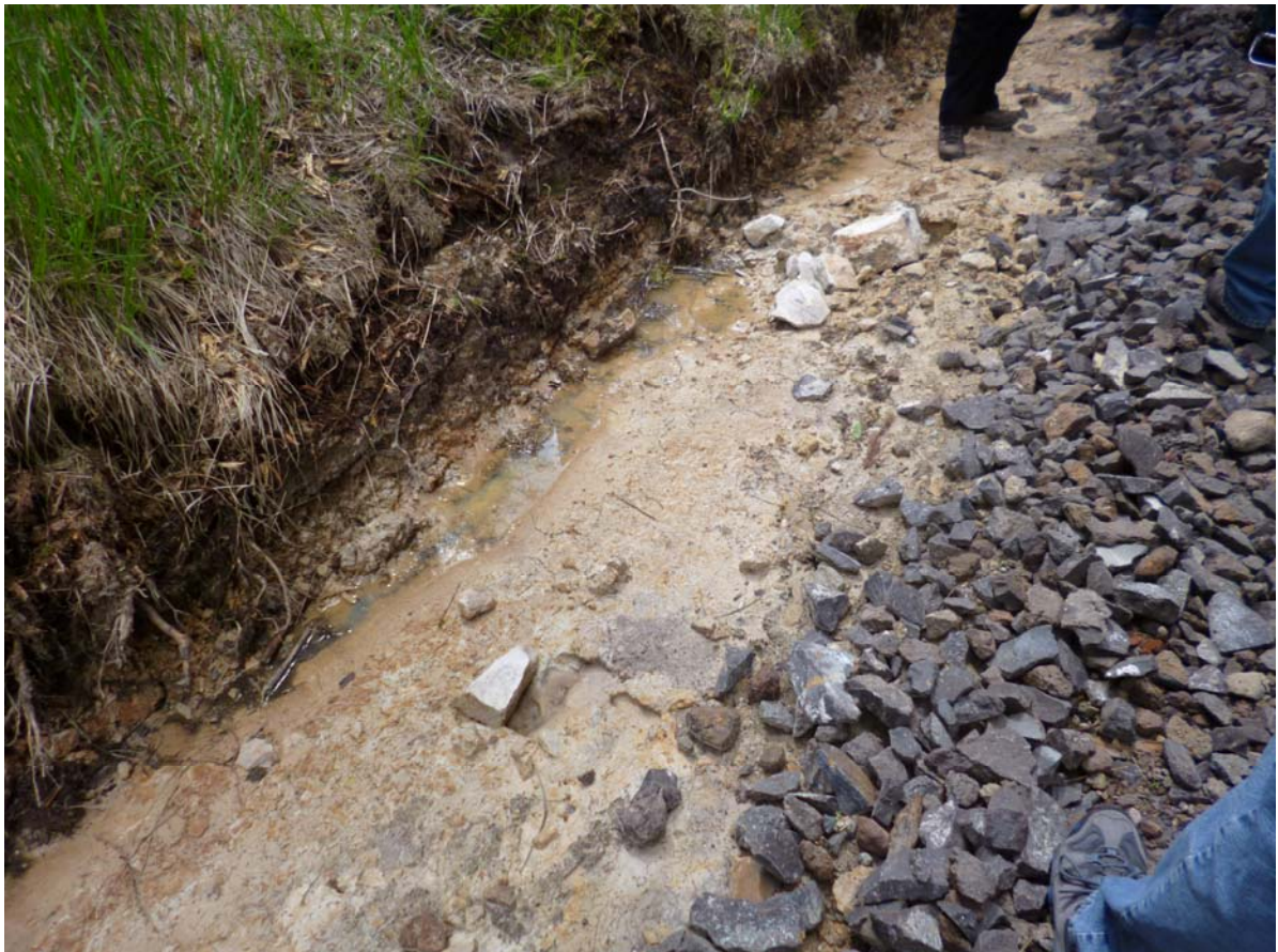
Rostflecken als Merkmal von Staunässe in einem Wegeseitengraben
