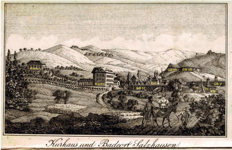
Abb. 7: Frontispiz (Kupferstich) zu MÖLLER (1835). Dargestellt sind Kurhaus (erbaut 1826), Kursaal (erbaut 1827), die Gradierbauten (GB) IV und V, jeweils mit einer aufsitzenden Windmühle (unter der Windmühle von Gradierbau V befand sich der Radbrunnen), der Hochbehälter über Brunnen I (Br. I) neben dem Kunsthaus (KH), das Glockenhaus (GH) sowie am Hang der Gradierbau VI und der runde Gradierbau VII. Die übrigen Gebäude und Einrichtungen können nicht mit Sicherheit zugeordnet werden.
